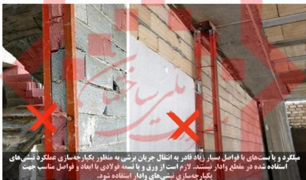
شکل پ-۷-۶ ایراد متداول مربوط به بست‌های مورد نیاز جهت یکپارچه سازی مقطع وادار
