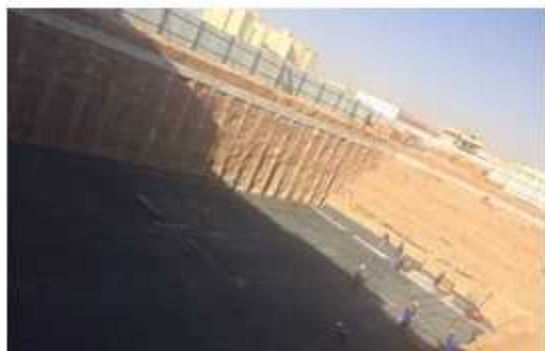
۵- شروع مقدمات عملیات اجرای فونداسیون
