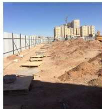
۱- احداث تأسیسات مربوط به دیوار حفاظتی
