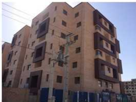
۳- تکمیل عملیات نماسازی
