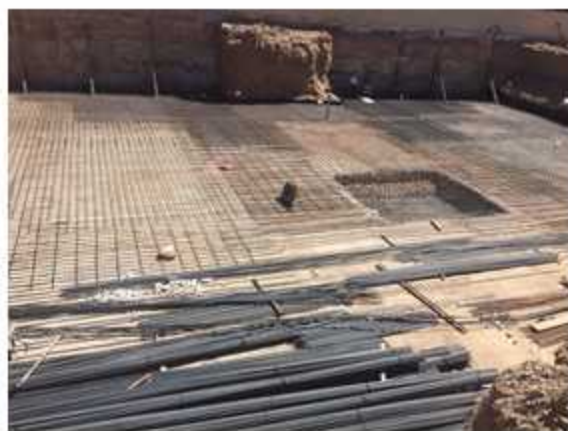
۲- شروع مقدمات عملیات اجرای فونداسیون
