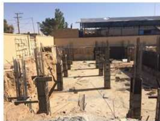
۳- اجرای فونداسیون و ستون های زیرزمین
