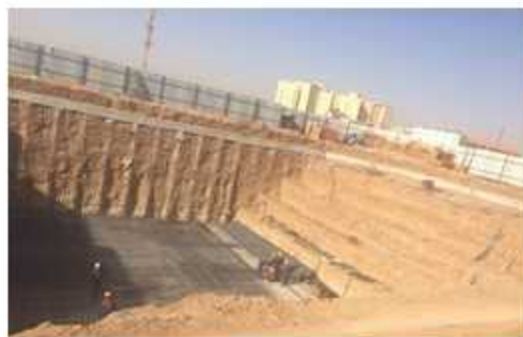
۴- شروع مقدمات عملیات اجرای فونداسیون
