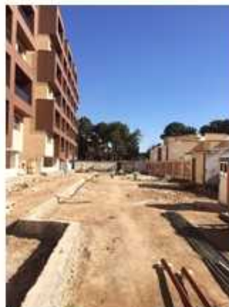
۵- شروع عملیات محوطه سازی در ضلع جنوبی
