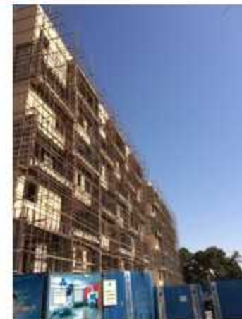
۱- داریست جهت شروع عملیات نماسازی
